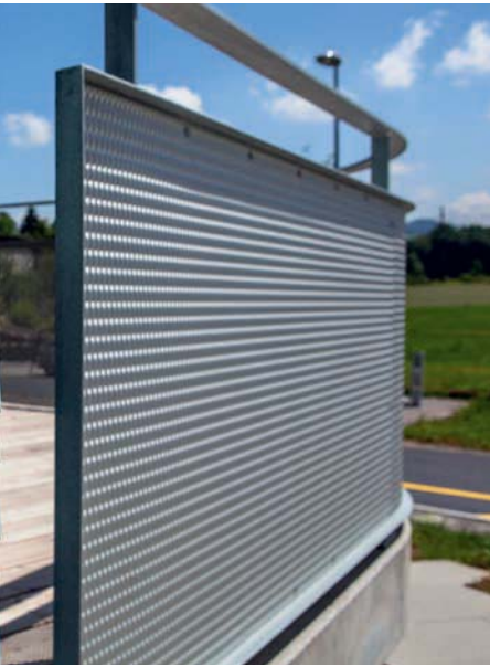
Auch Details wie die Balkongeländer wurden äusserst sorgfältig gestaltet.
