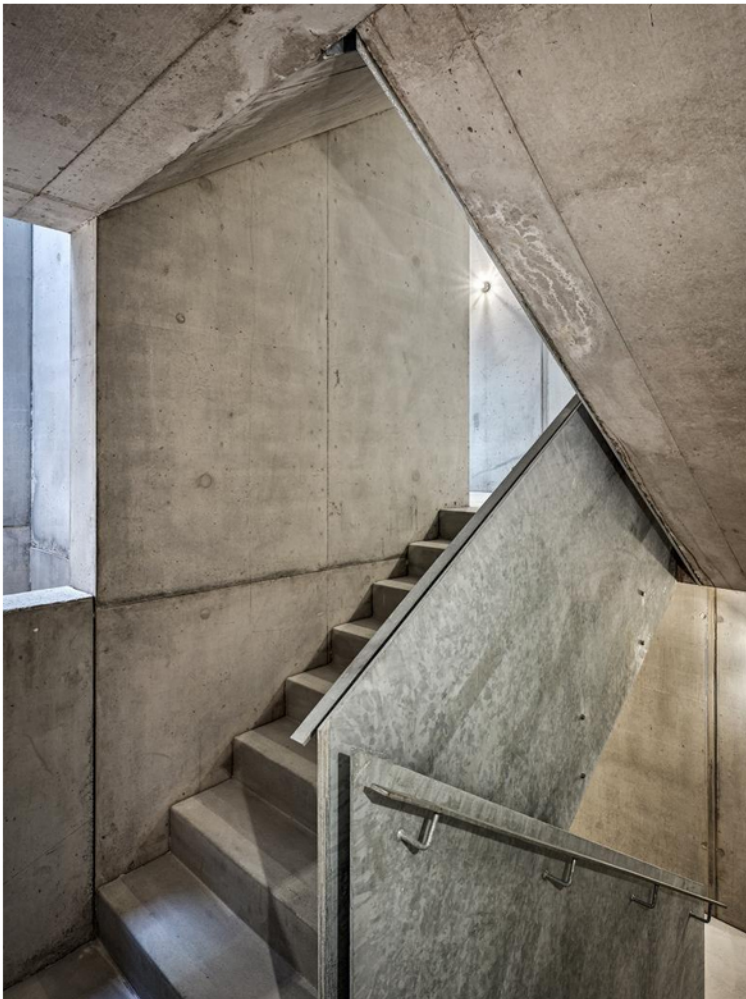
Blick ins roh belassene Treppenhaus mit natürlichem Zenitlicht (Foto: Roger Frei)
