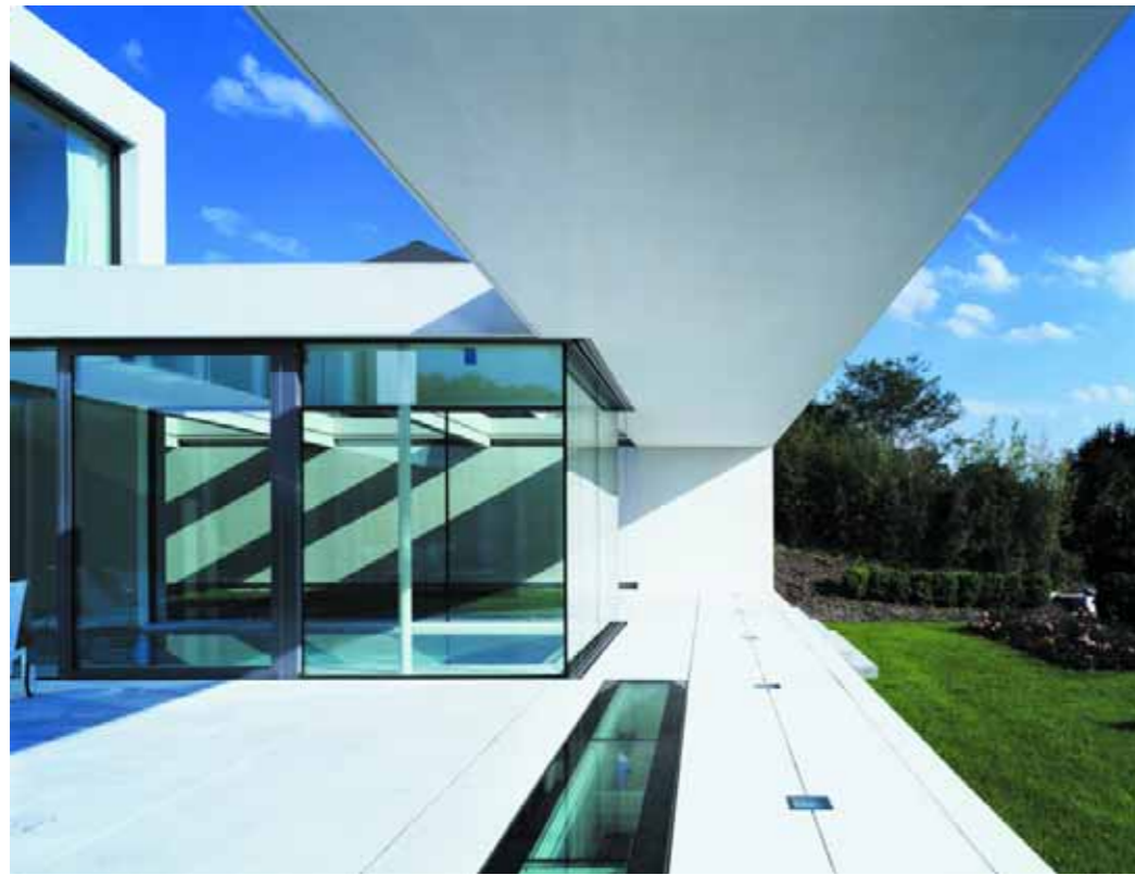
Der Pool grenzt unmittelbar an die geschützt liegende Terrasse. Über ein im Boden eingelassenes Glasband erhalten auch die Räume im Untergeschoss natürliches Licht.
