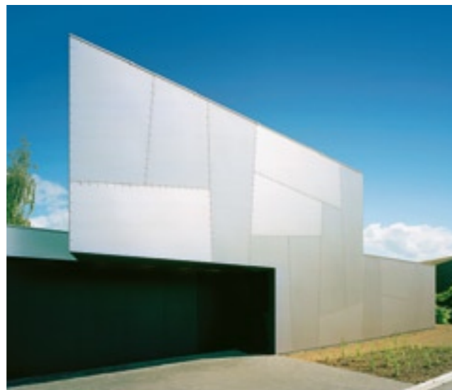
ALUMINIUMVERSCHALT Einfamilienhaus in Lachen SZ
